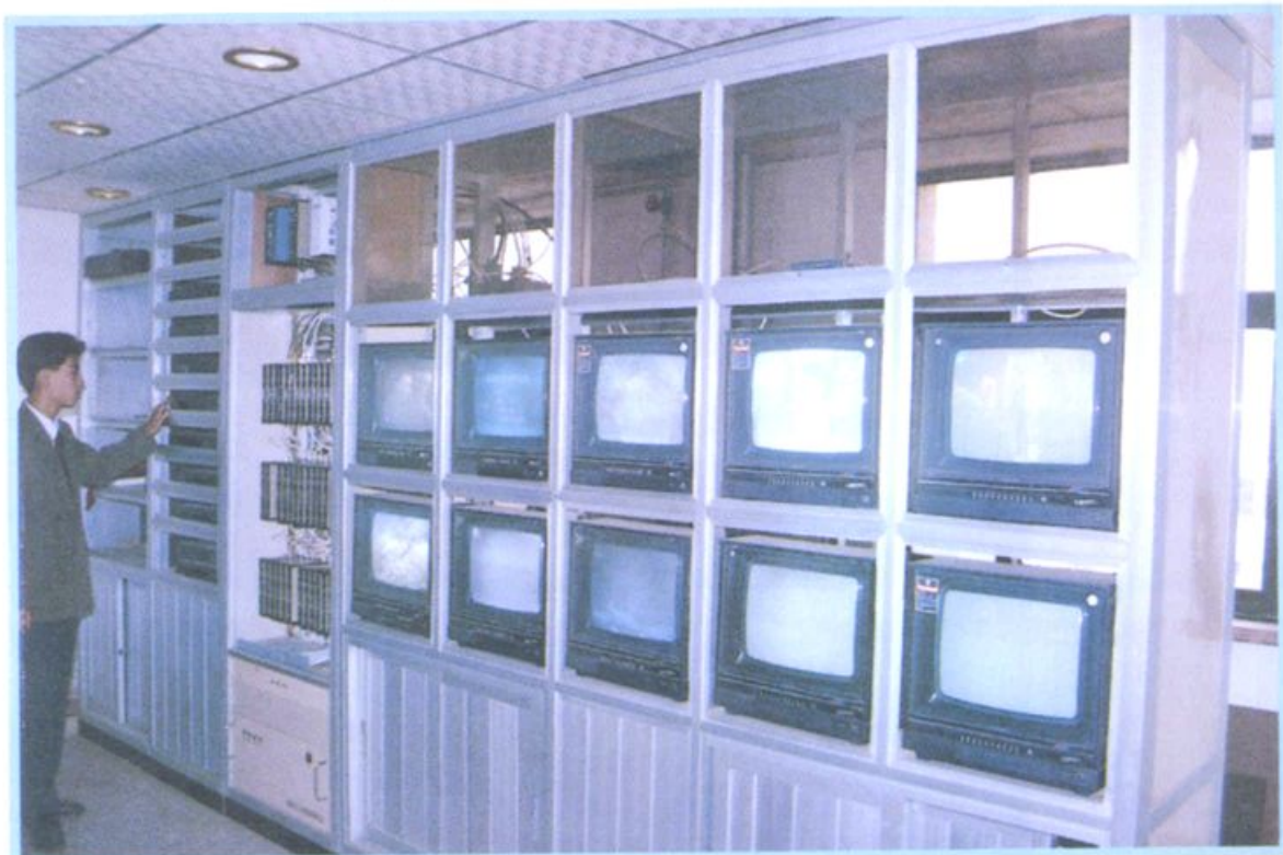
△有线电视台机务人员在工作
