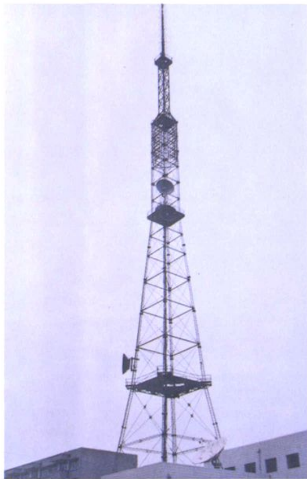
▽ 寿光电视台 124 米电视发射塔
