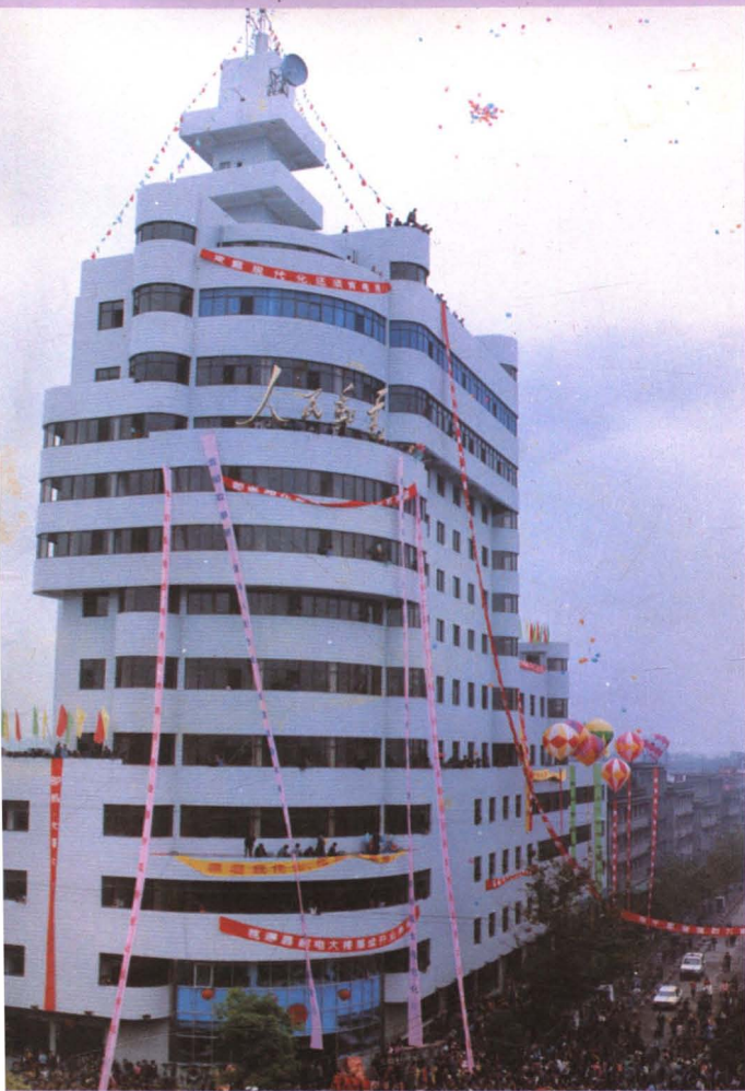
耸入云霄的桃源邮电大楼
