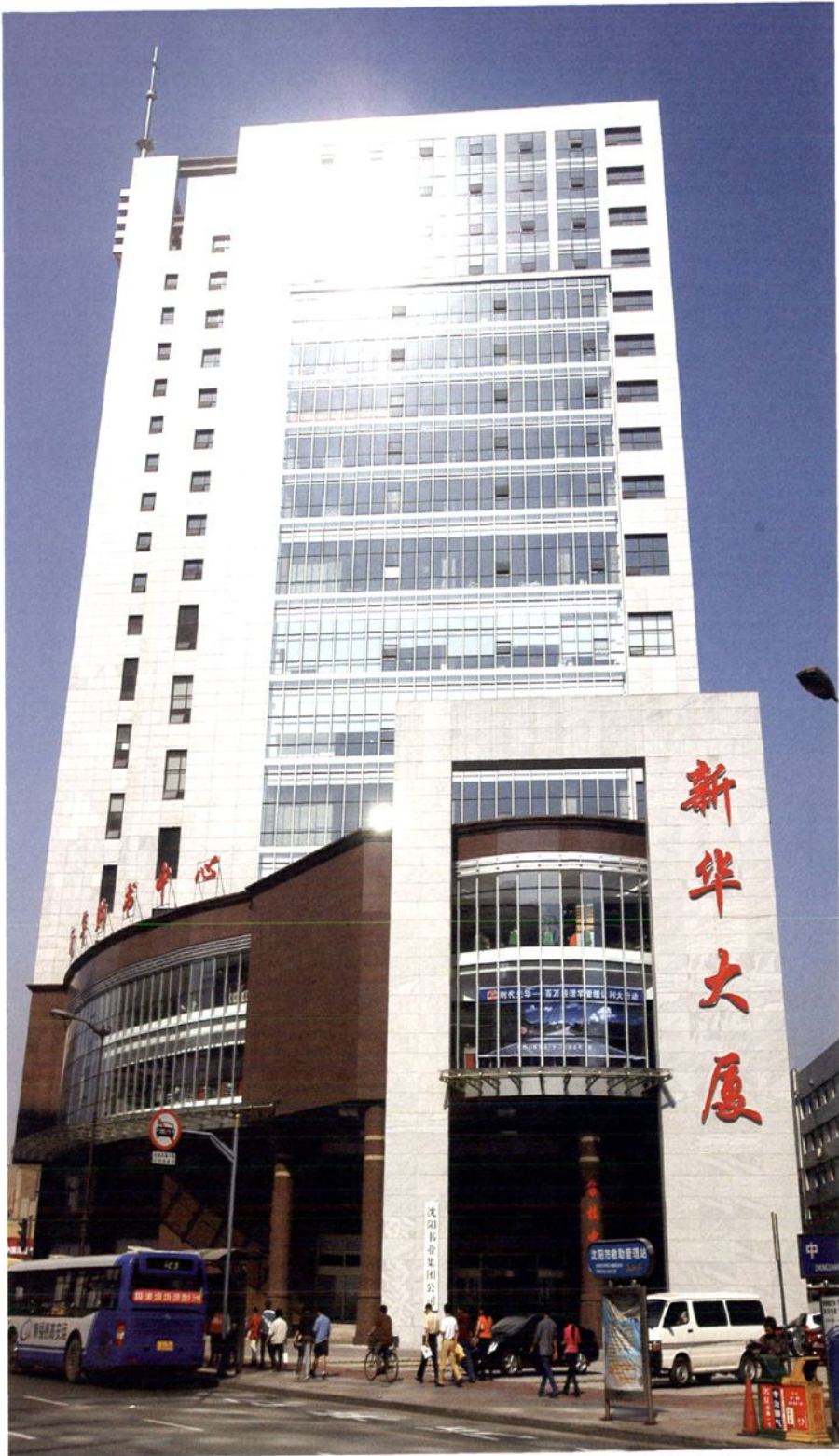
沈阳新华大厦
