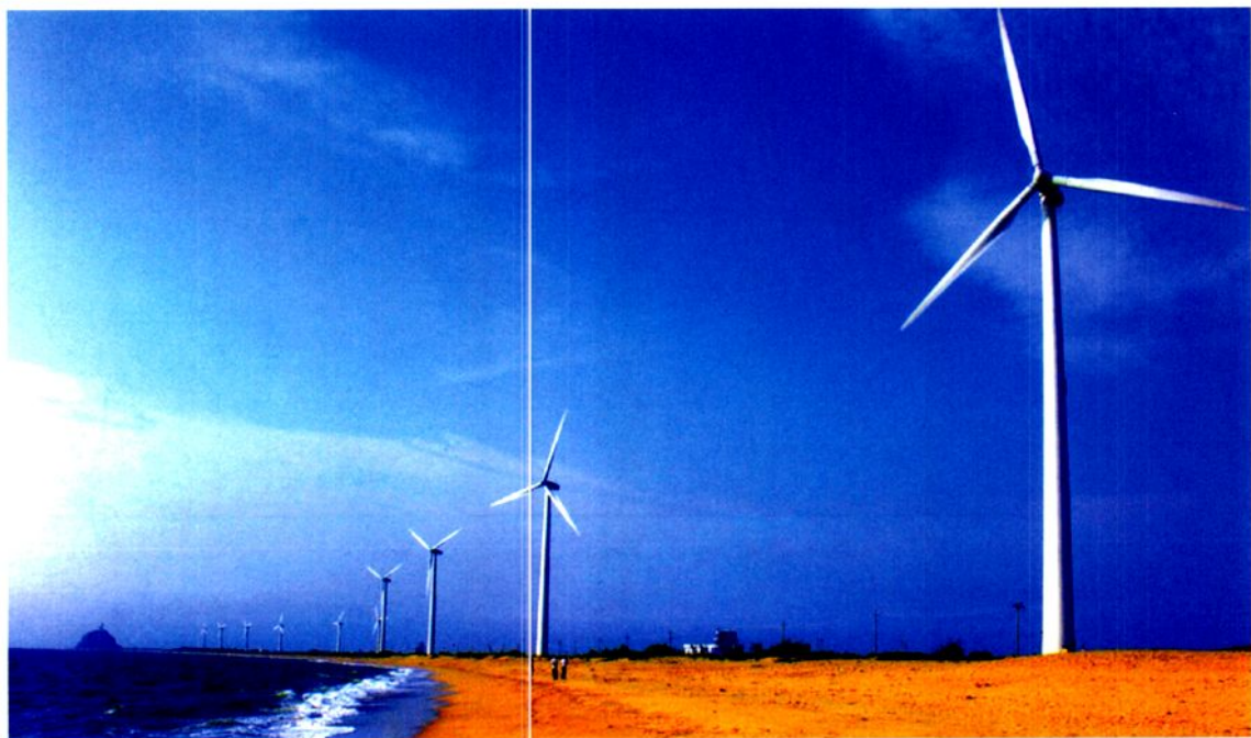
◆位于八所镇月亮湾的海南国信能源公司风力发电厂（1996年1月摄）
