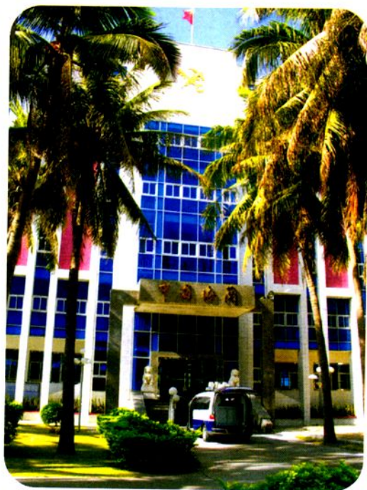
◆八所海关大楼（1997年2月摄）
