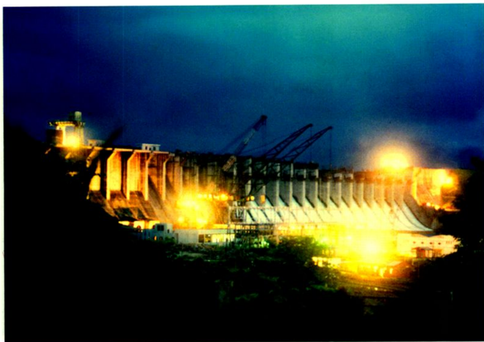
◆1993年大广坝一期工程施工夜景（1993年3月摄）
