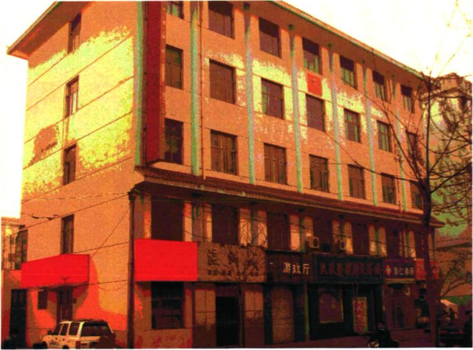
银川市林业技术推广中心办公楼
