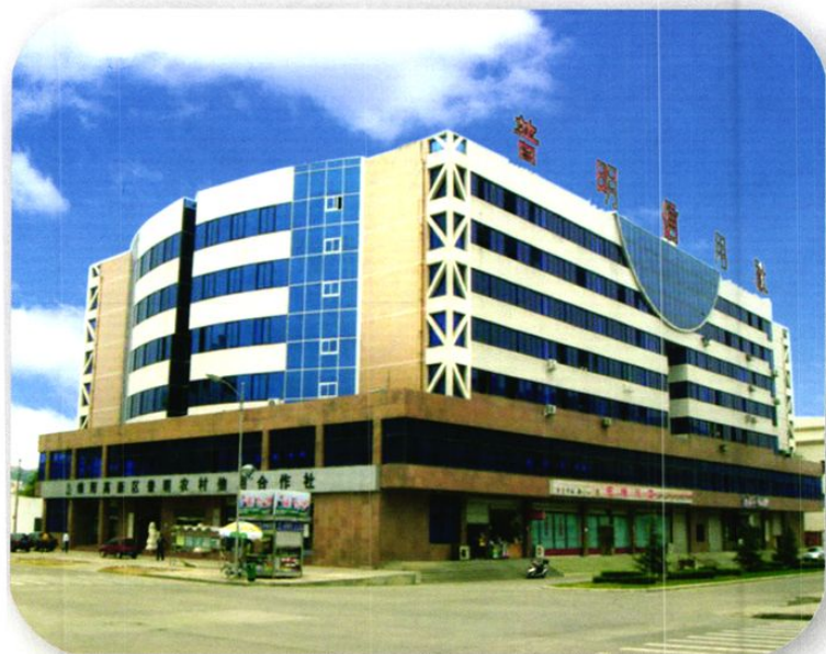
普明信用社新建的综合楼
