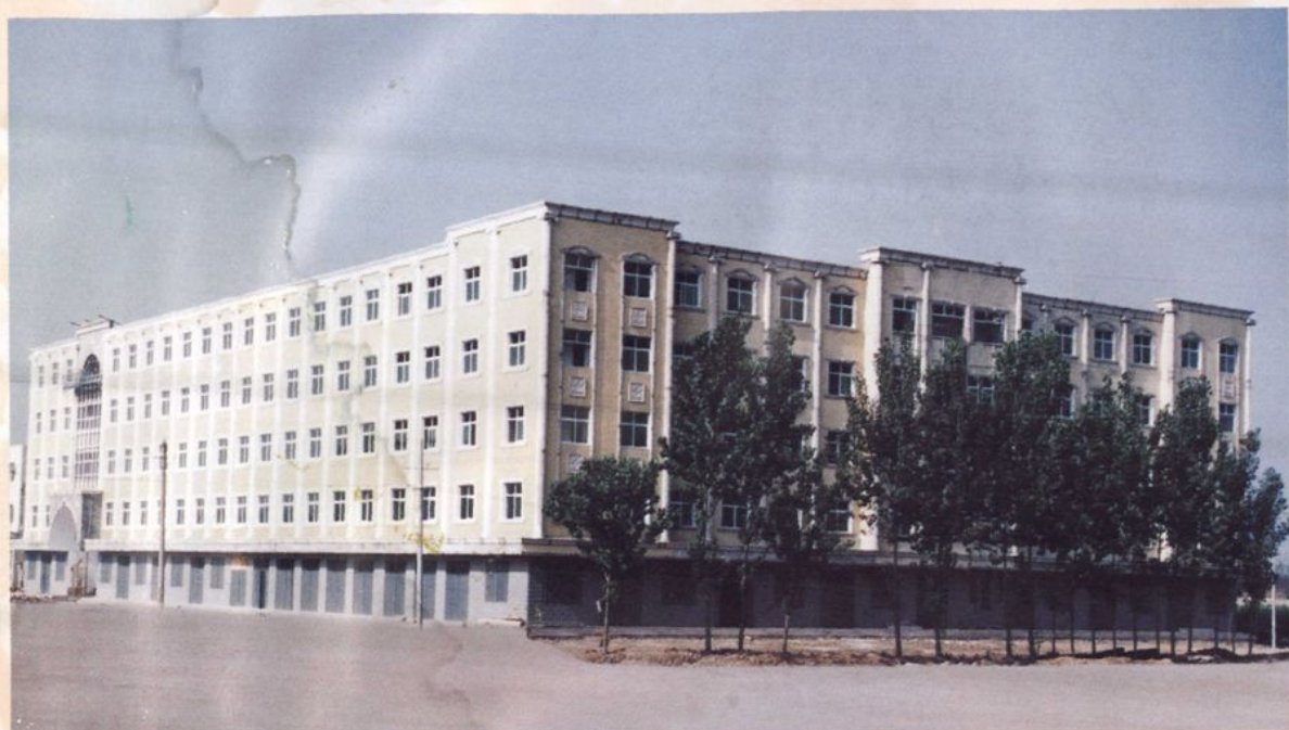
建设局办公楼
