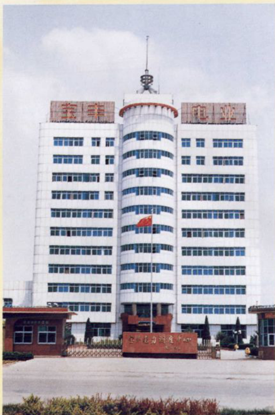
宝丰县电力调度中心
