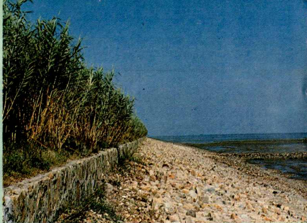
△ 吕四侵蚀性岸段保滩护坡
