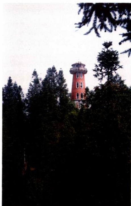
春蕾林场防火瞭望塔
