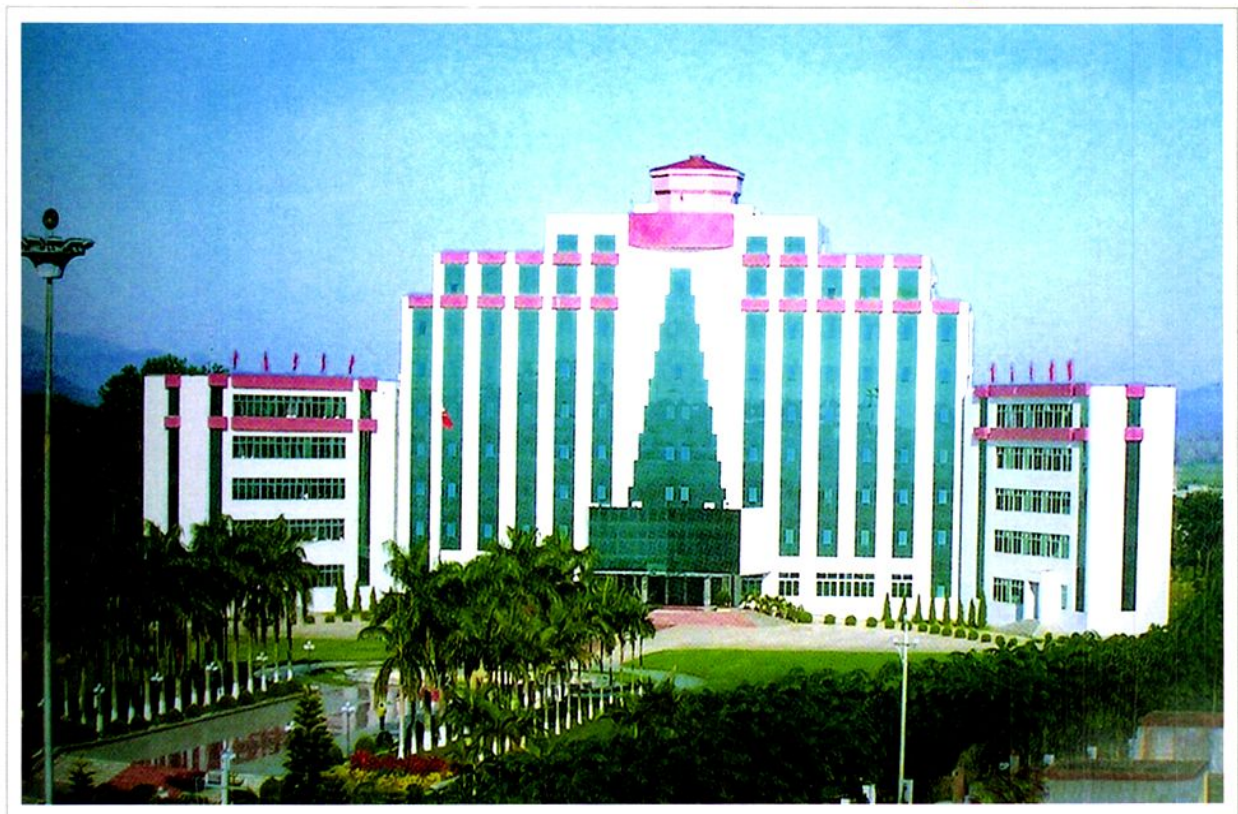
屯昌县委、县政府办公大楼（1996年落成）
