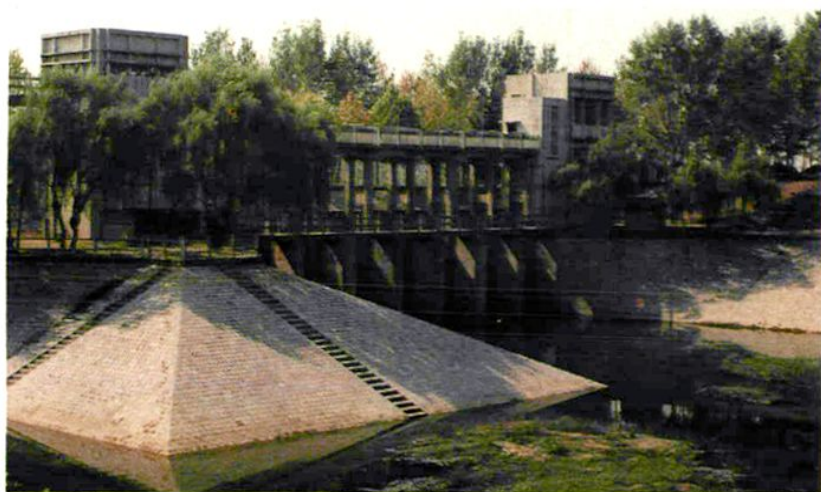
黄庄倒虹吸进水闸
