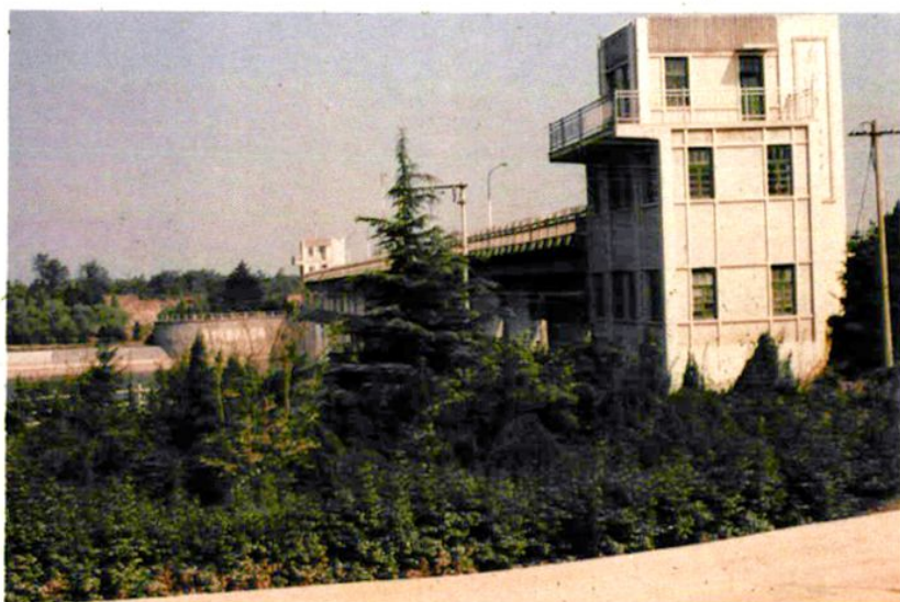
新沐河泄洪闸
