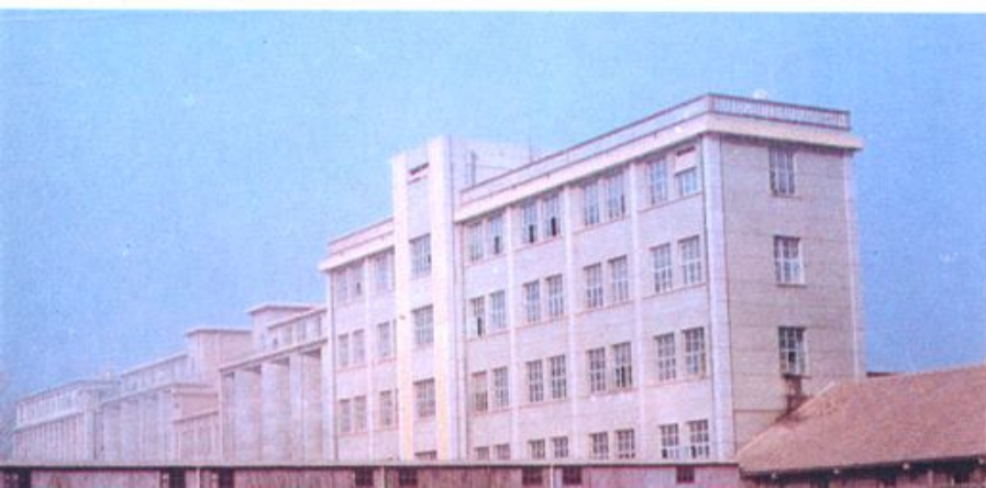
莱芜市面粉厂制粉车间外貌
