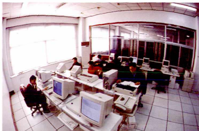
移动电话机房
