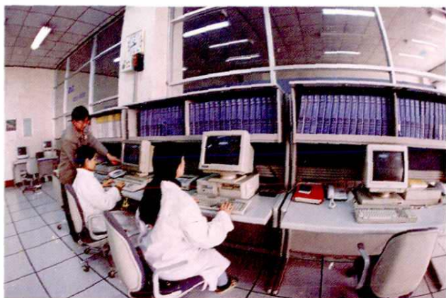
长途交换机房值班室
