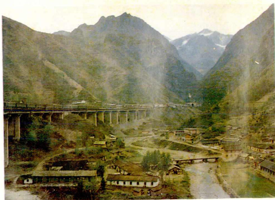
襄渝铁路巴山车站
