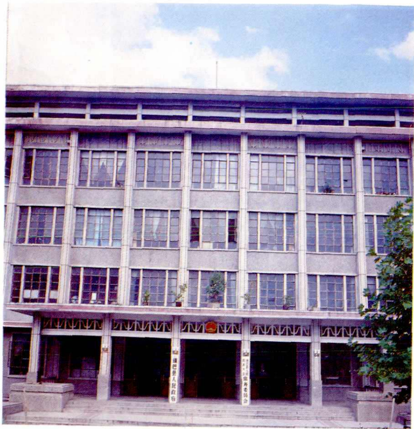
镇巴县人民政府办公楼
