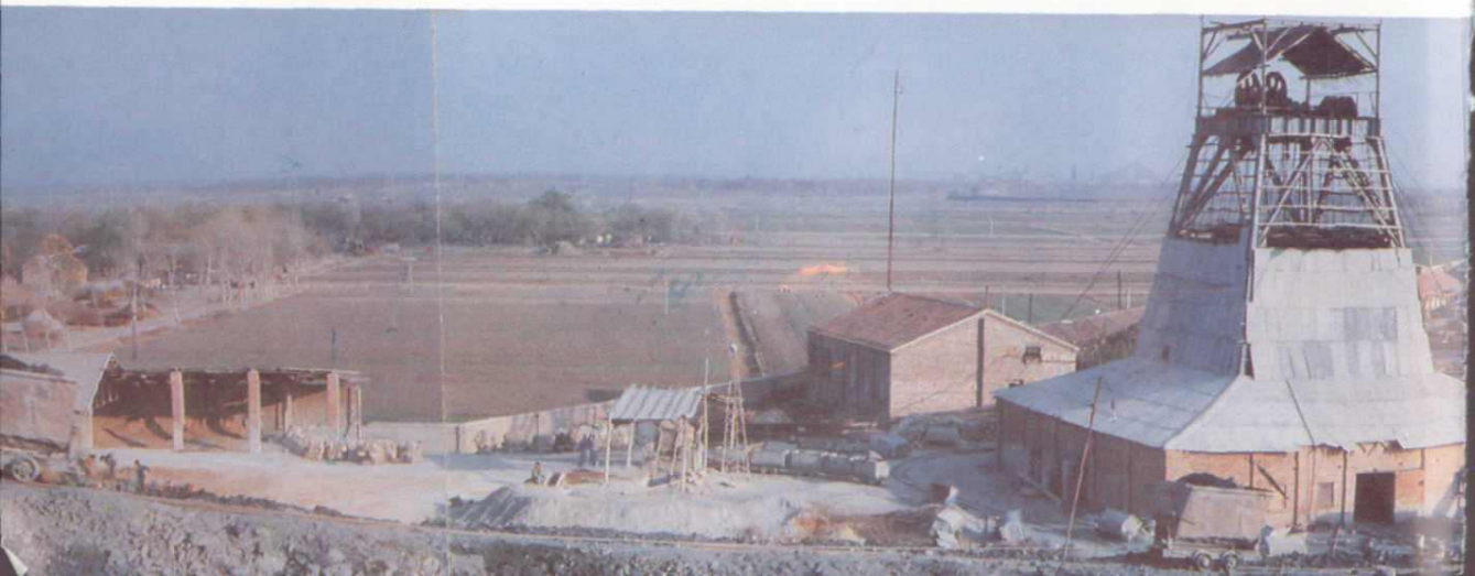
矿井施工现场
