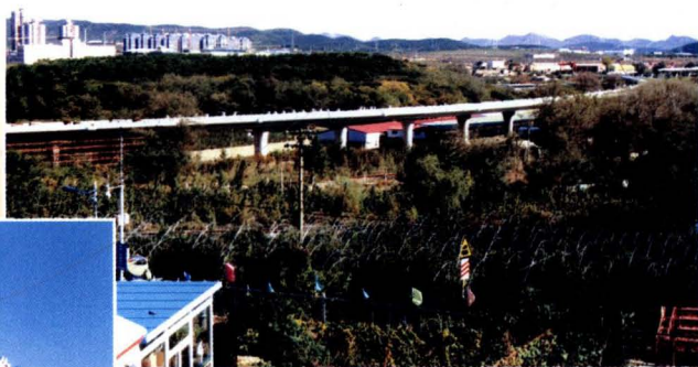
建设中的 202 轻轨
