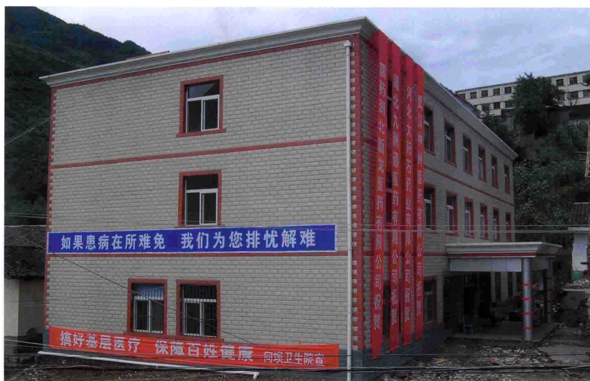
▲新建向坝乡卫生院门诊综合楼。
