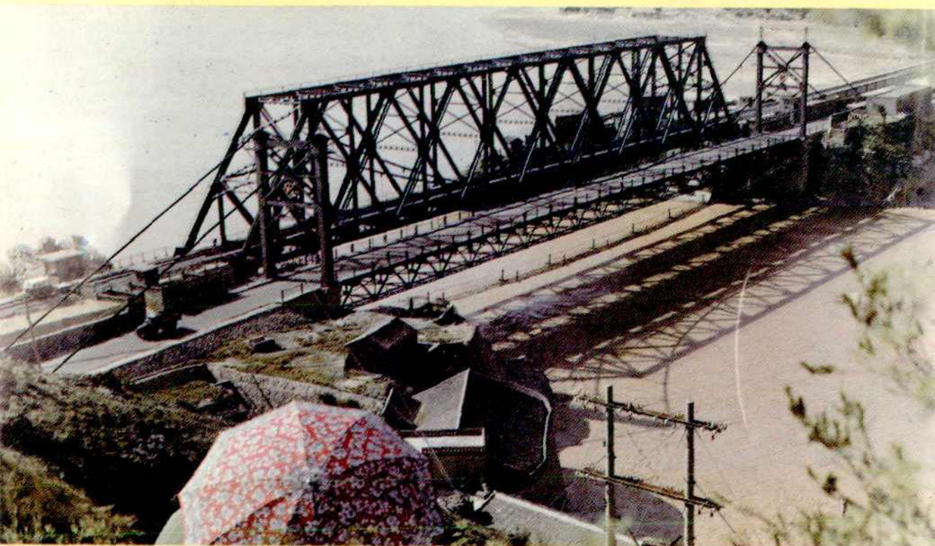
禹門鐵路、公路橋
