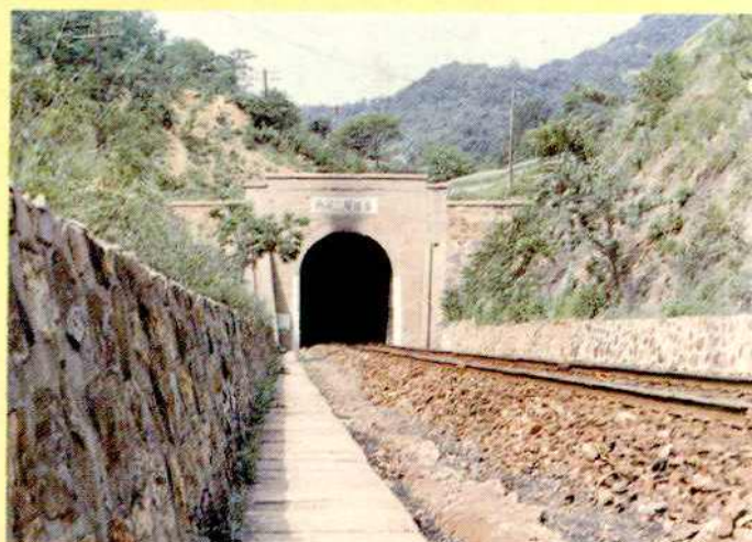
西溝二號隧道
