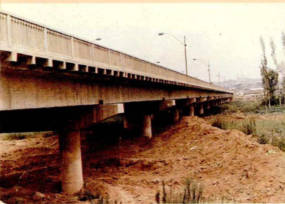
新絳汾河大橋
