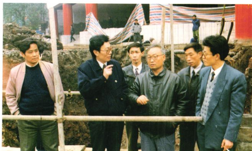
→市委常委、市 政府副市长、市人防 委主任何征修亲临公 园口人防工程施工现 场。
