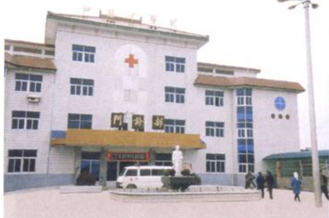
泗阳中医院门诊楼
