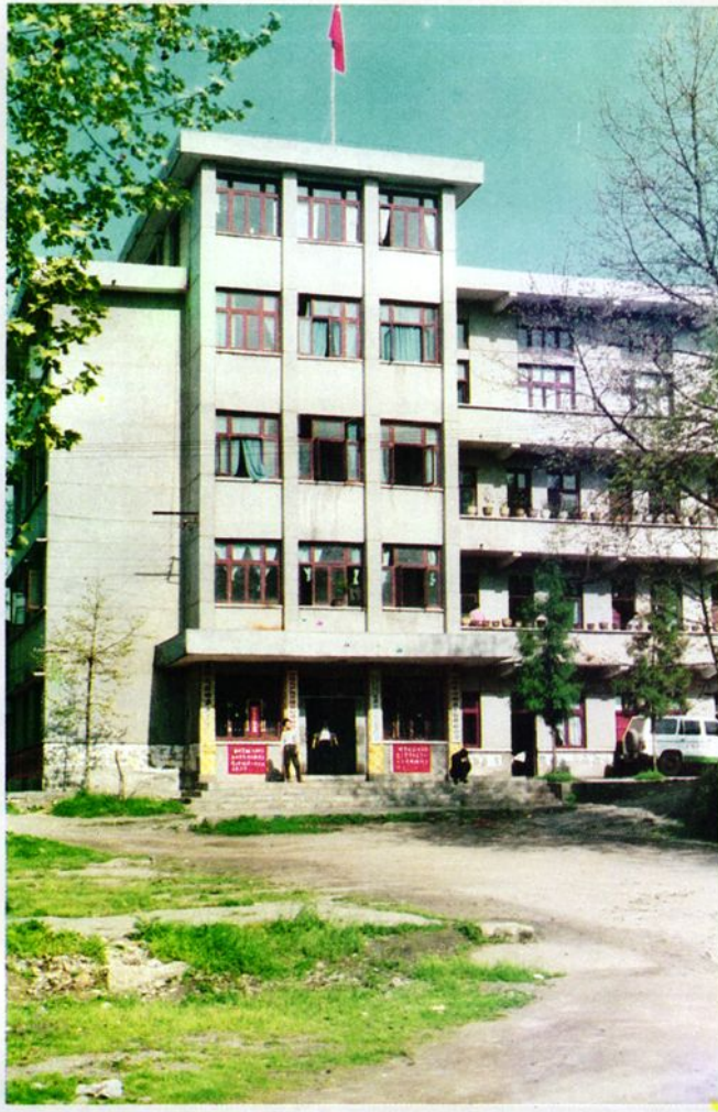
政协贵州省开阳县委员会办公大楼
