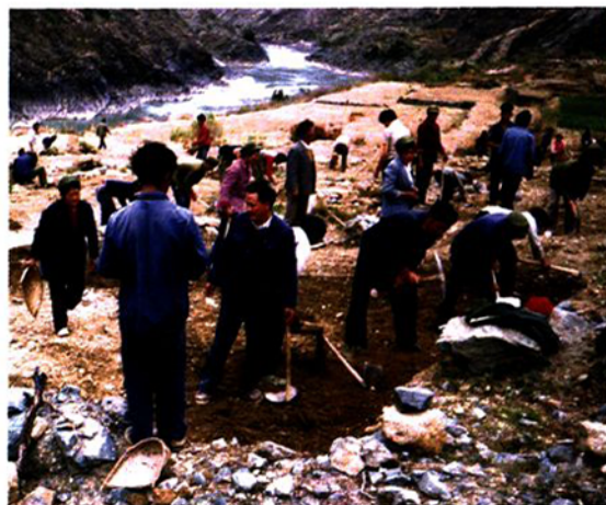
九届政协领导在尼西“吉玛塘”开发施工现场
