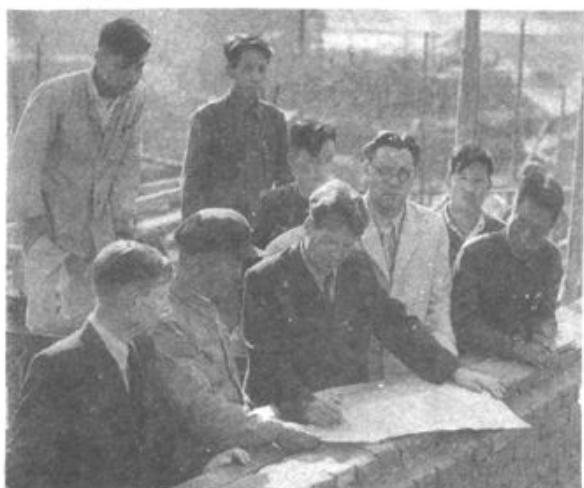
苏联专家在勘察施工现场
