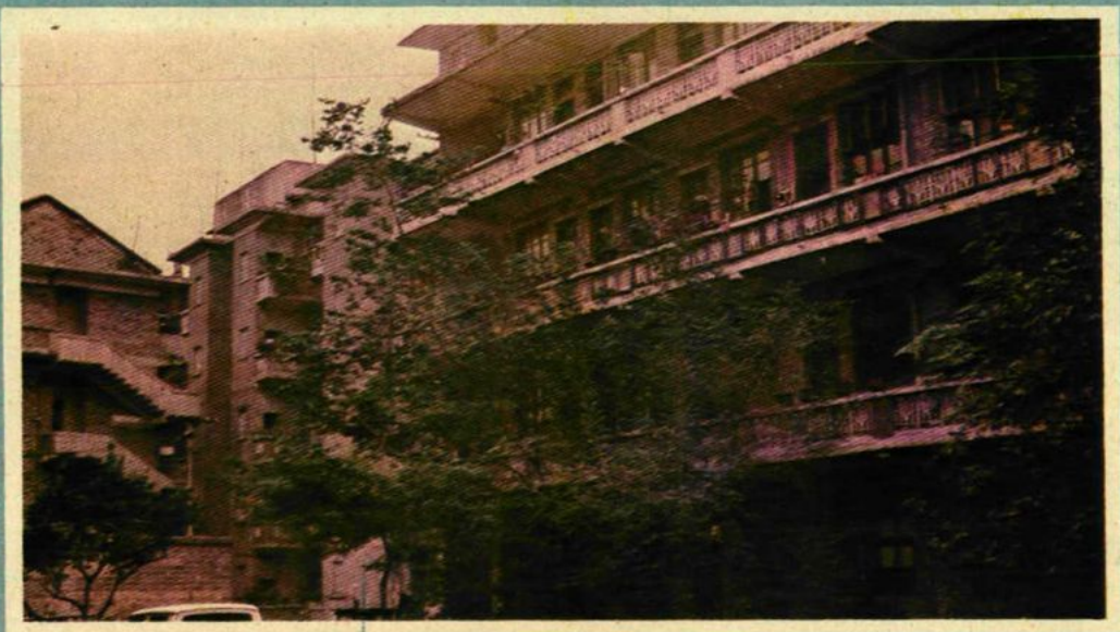
县卫生防疫站办公楼
