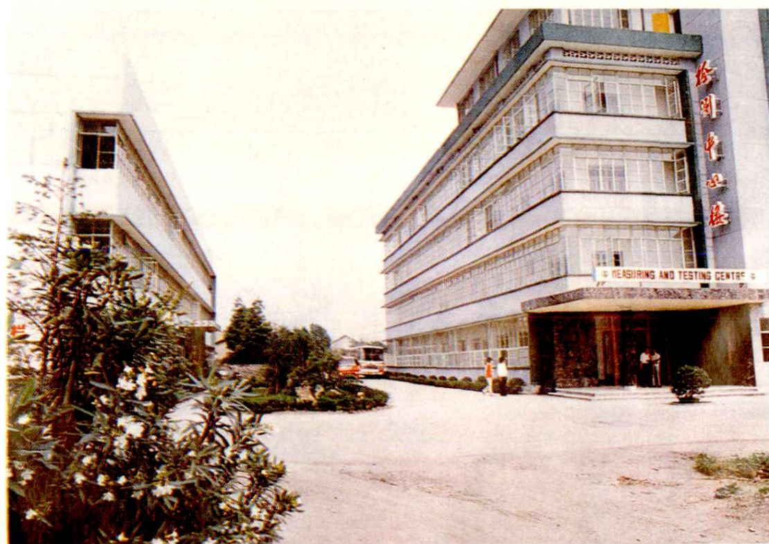
桐乡煤矿机械厂检测中心楼
