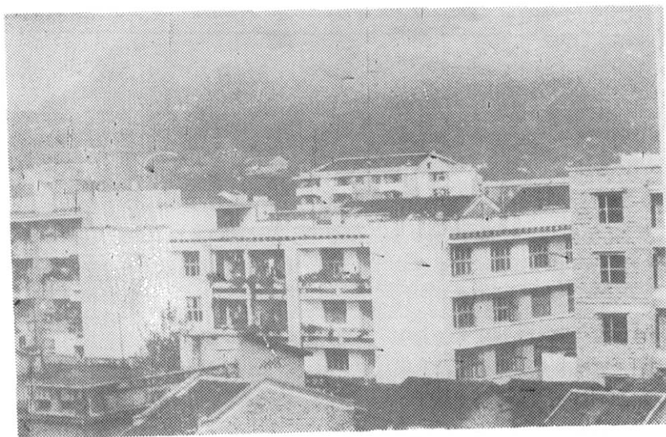
购销公司办公大楼
