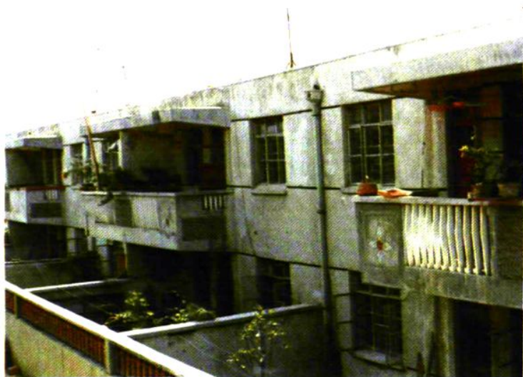
矿区分局家属宿舍楼
