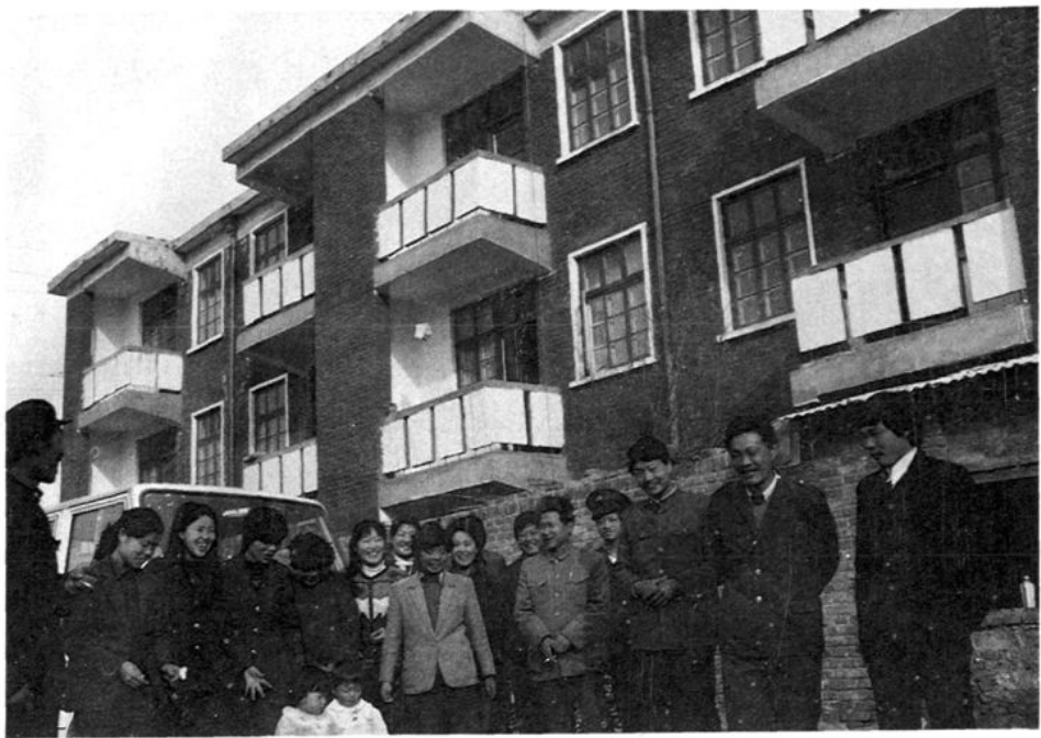
郑州车务段集体企业从无到有蓬勃发展，为职工子女广开了就业门路，解除了职工的后顾之忧。图为临颖车站大集体新建的住宅楼。
