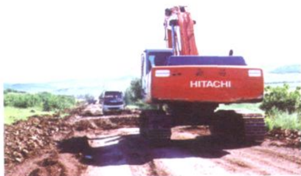
2006年杜宝水泥路面公路开工
