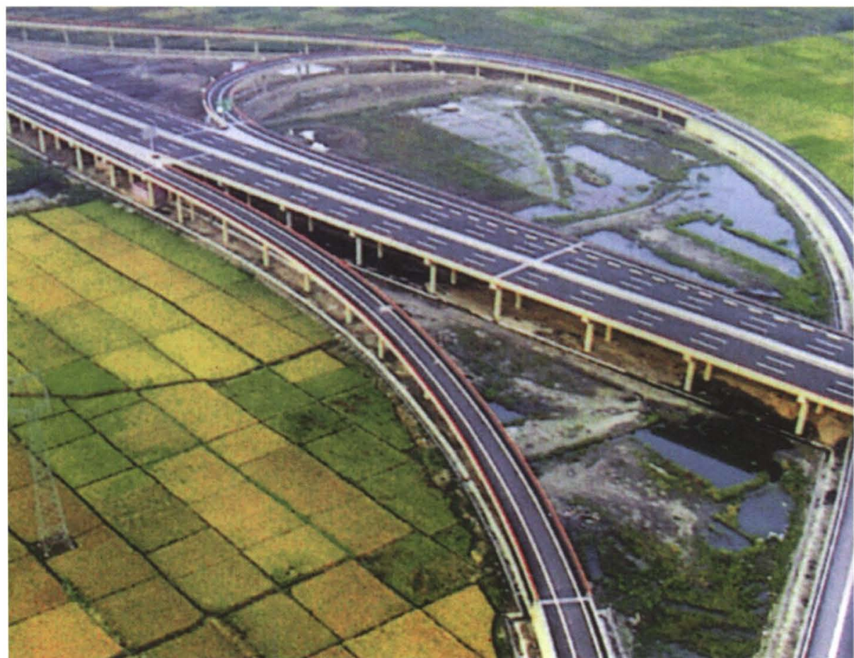
▲ 大运高速公路
