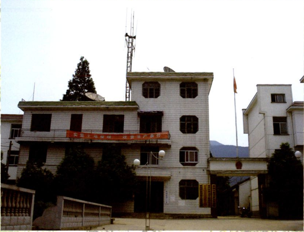
政府办公大楼
