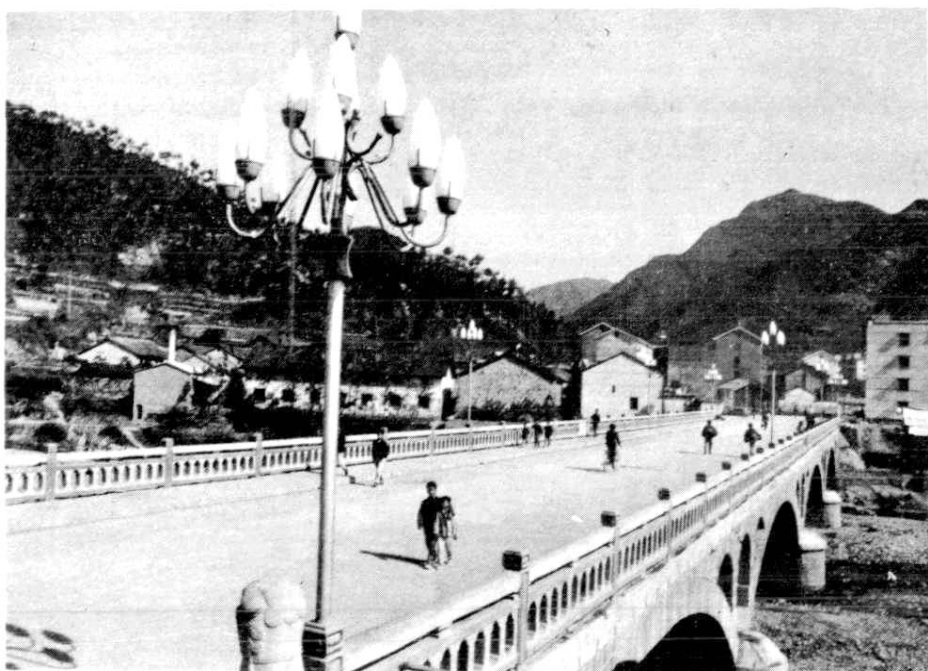
▲ 新建的海螺桥
