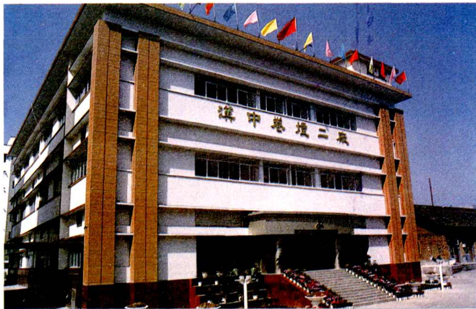
◀ 汉中卷烟厂二分厂办公大楼
