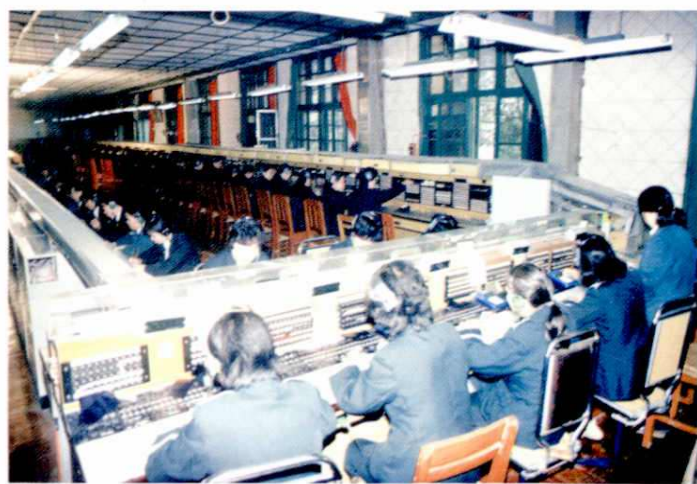
▲长途电话人工接续台机房
