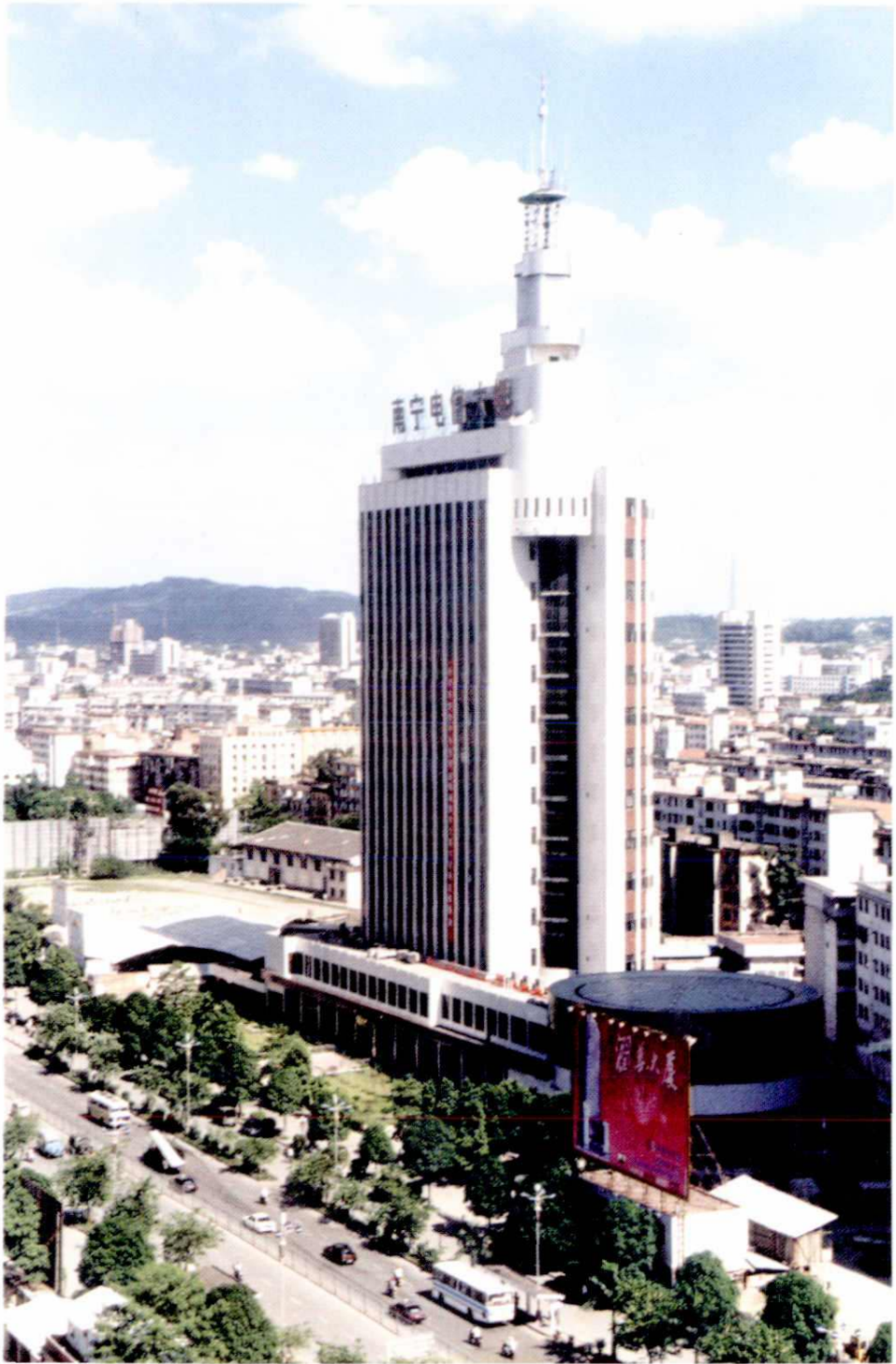
南宁电信枢纽大楼
