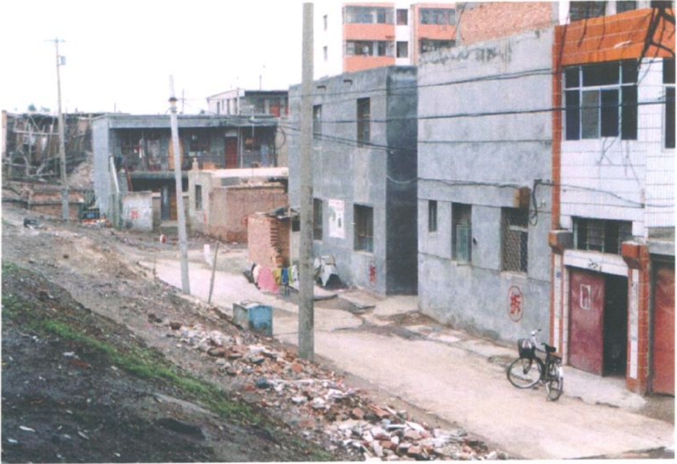
综合整治前唐徕渠堤旁的脏乱差景况
