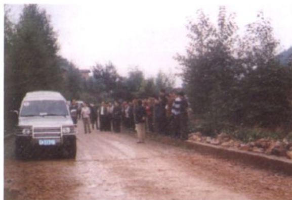
▲ 视察通乡油路工程建设情况
