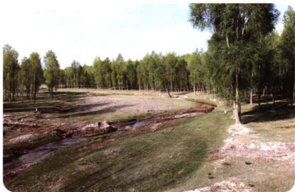
马营河流域河床治理
