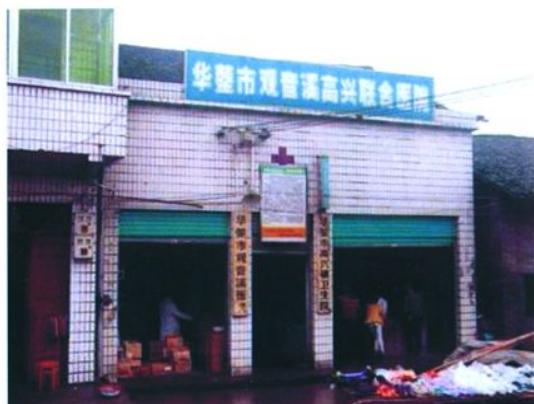
建设前的高兴镇卫生院
