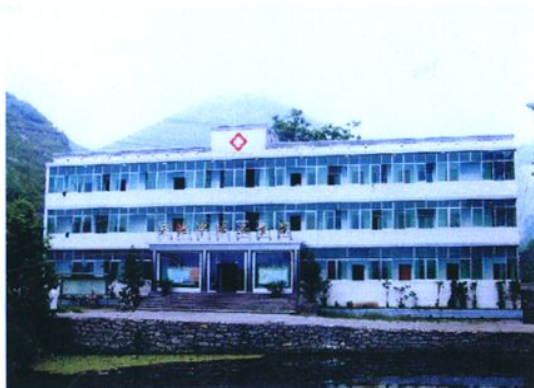
装饰后的天池镇中心卫生院
