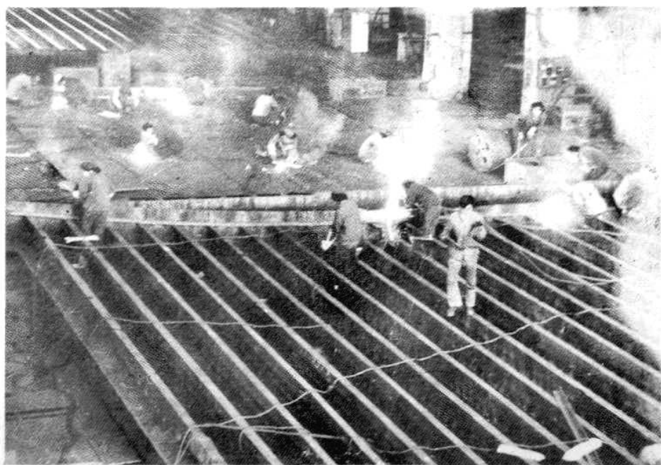
↑ 船舶双层底施工现场
