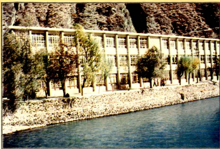
□、县中学教学大楼
