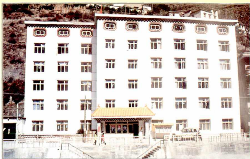
□、县委、人大、政协办公大楼
