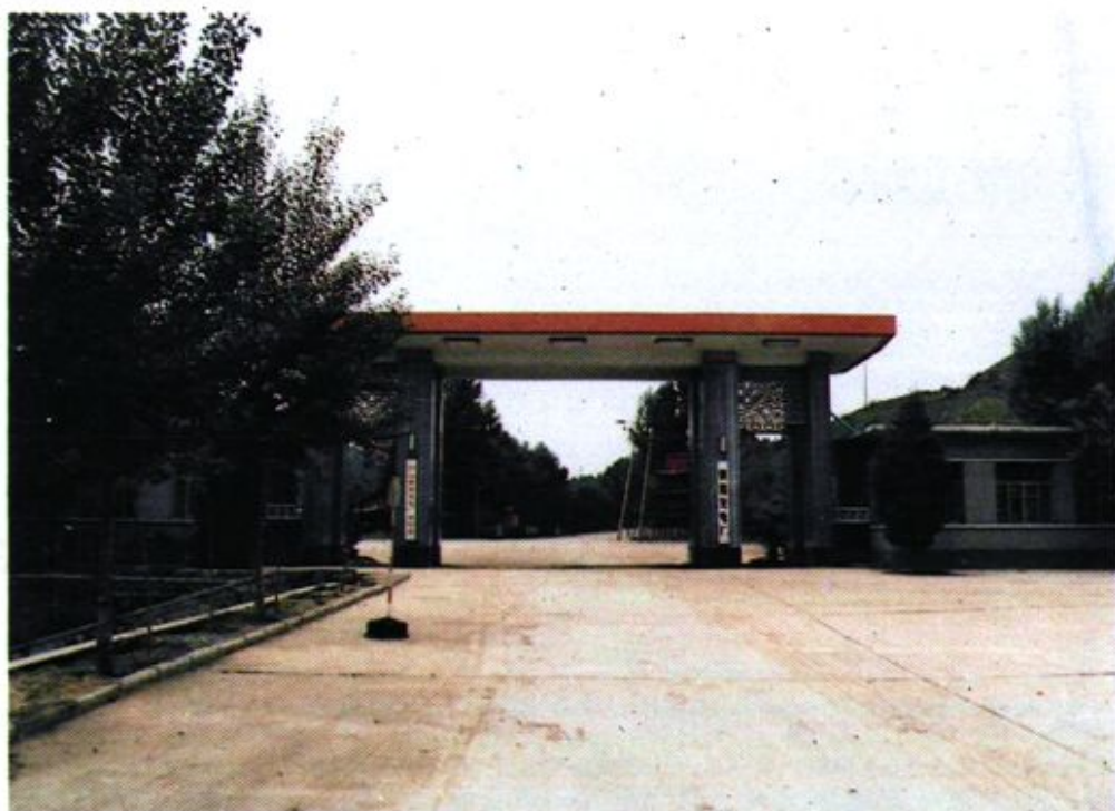
朝阳发电厂正门
