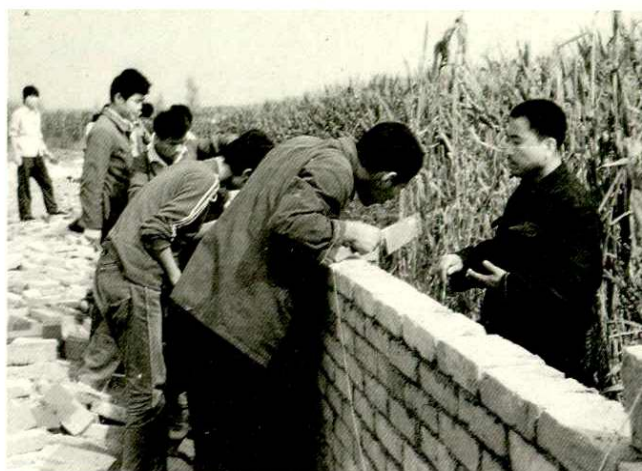
牛东职业中学建筑专业班学生现场实习
