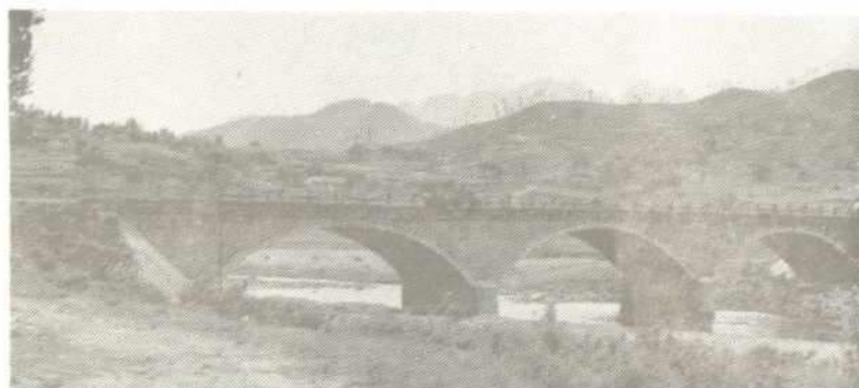
秦青公路头道河石拱桥
