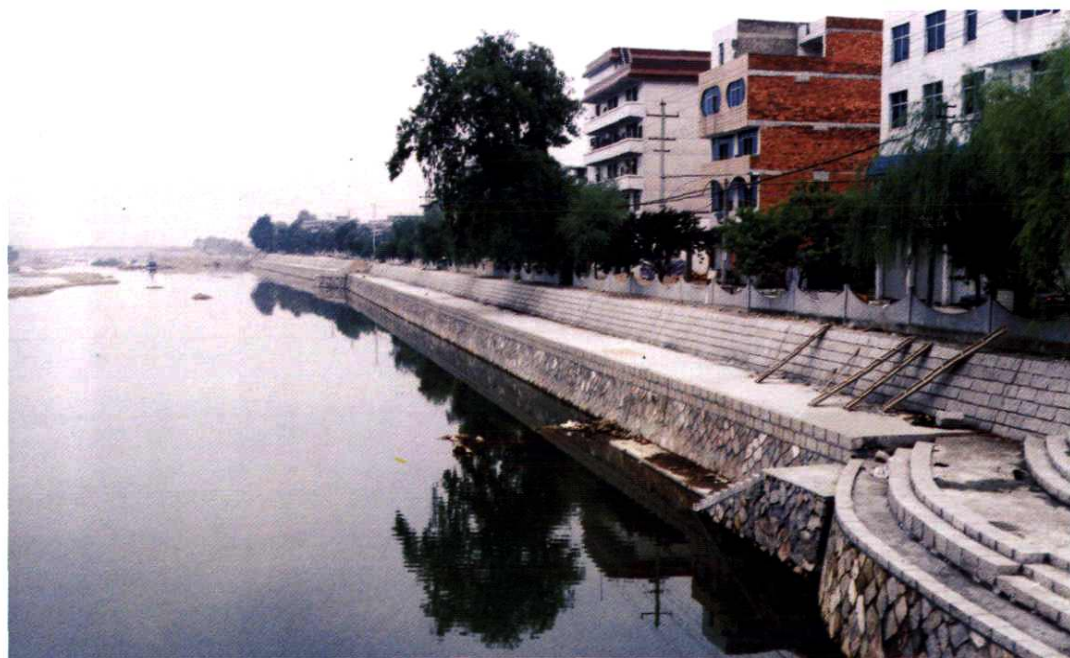
省防洪试点镇——古市镇一期防洪工程
