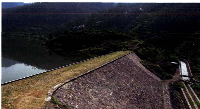
除险加固后的东坑弄水库
