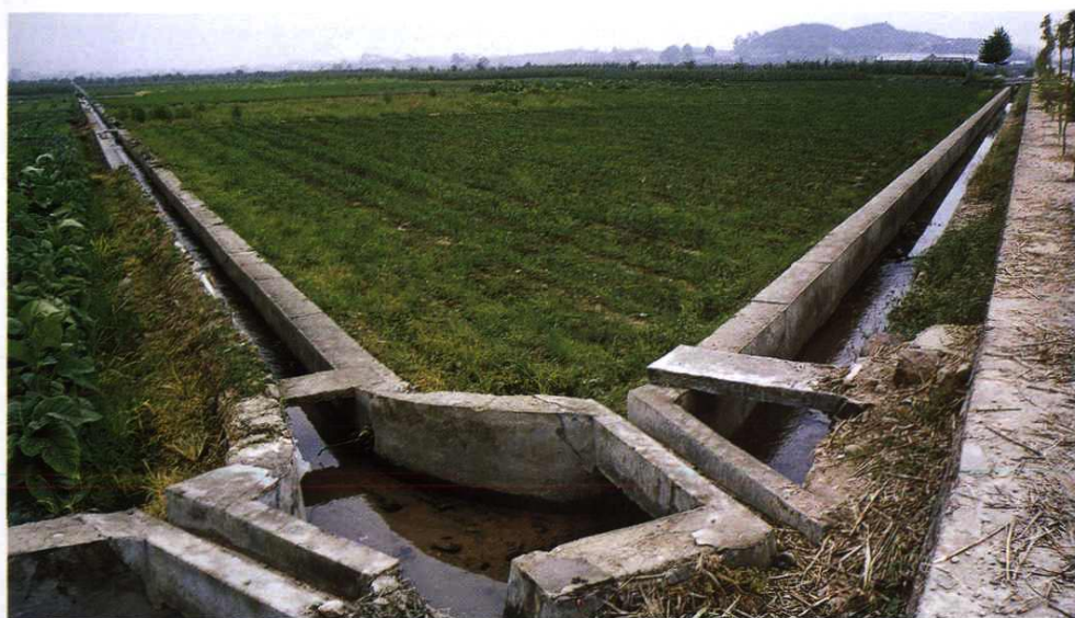
田间渠系配套工程
