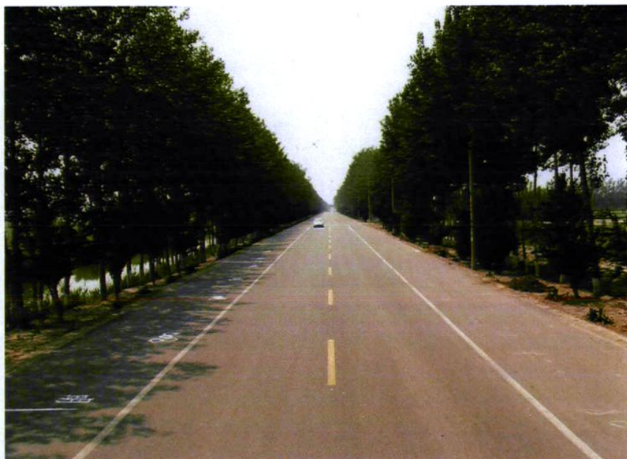
县道起马公路 西三村~华沟村路段
