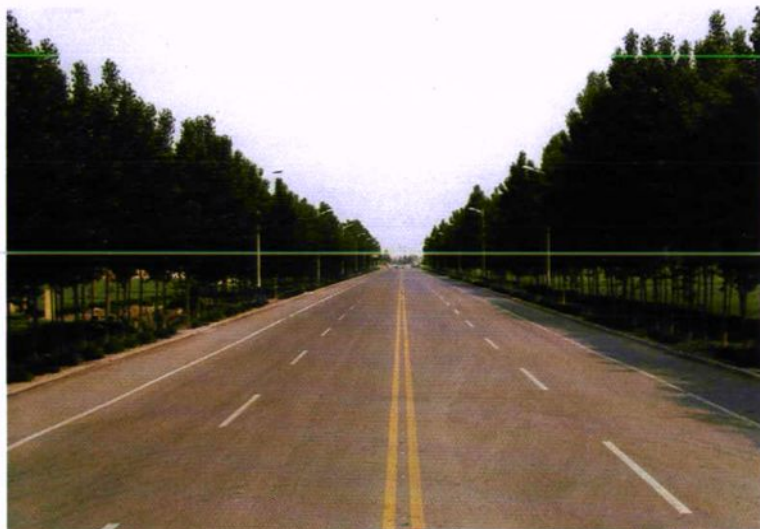
县道耿焦公路 邢家境内路段
