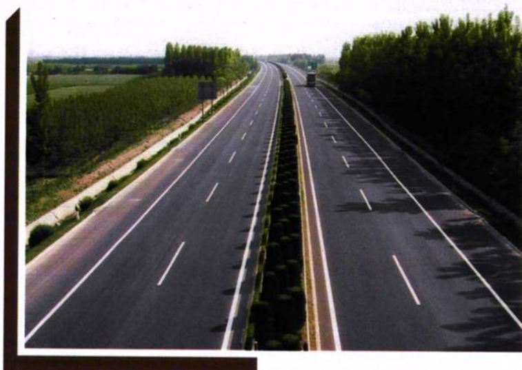
国道G205高速公路 新城境内路段
