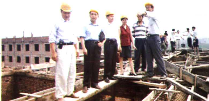
资阳市房地产管理局局长王用林(左三)在施工现场
