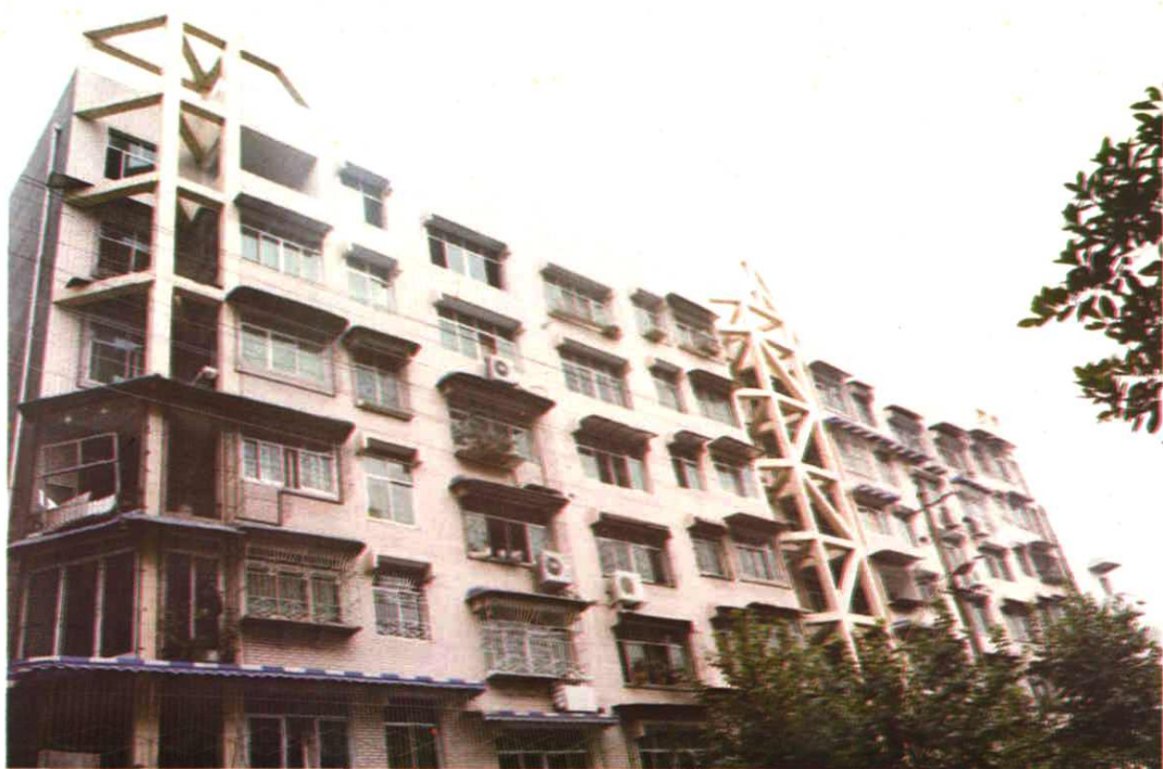
资阳市鼎立建筑安装工程公司承建的农业银行住宅楼
