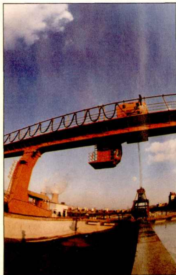
● 新海发电厂煤灰处理场
