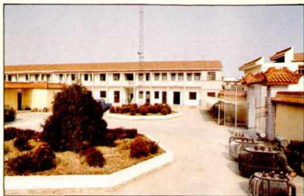
● 东海县浦南电力管理站
