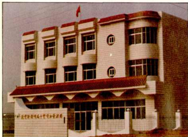
● 连云港市郊区中云电力管理站
