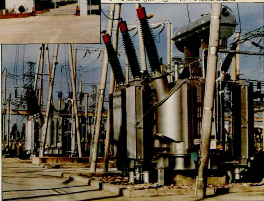
● 茅口变电所 2 台 12 万千伏安主变压器
