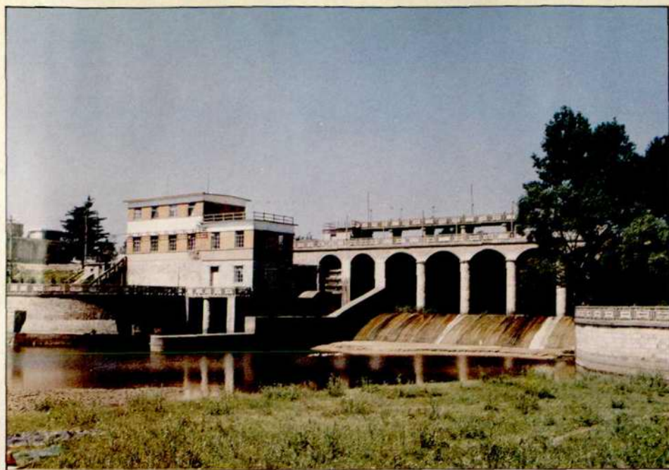
● 东海县青湖水电站
