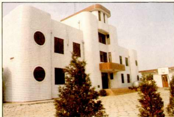
● 赣榆县墩尚电力管理站
