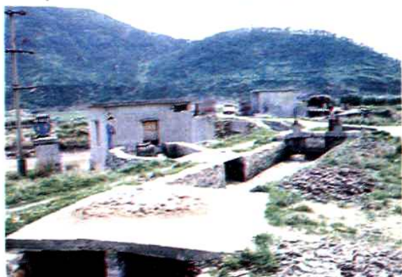
机械翻水及节制闸
