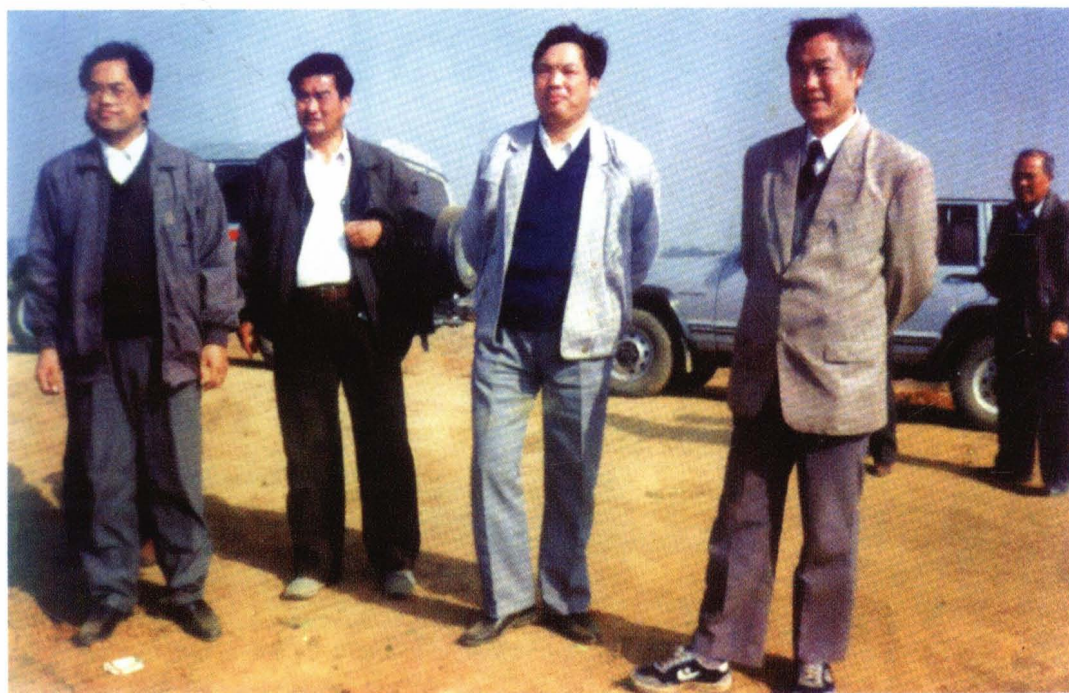
1992年10月，省公路管理局局长唐生德（右一）、市委副书记王孝忠（右二）、临澧县委书记李大伦（左一）检查207国道临澧段改建工程质量和进度。
