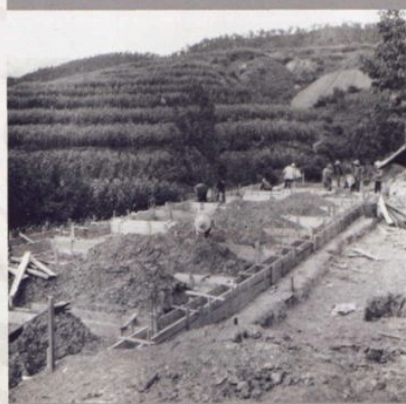
破土修建教学楼
