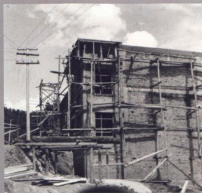
修建中的教学楼
